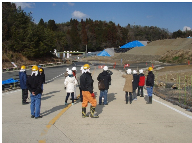
最終処分場の見学の様子
